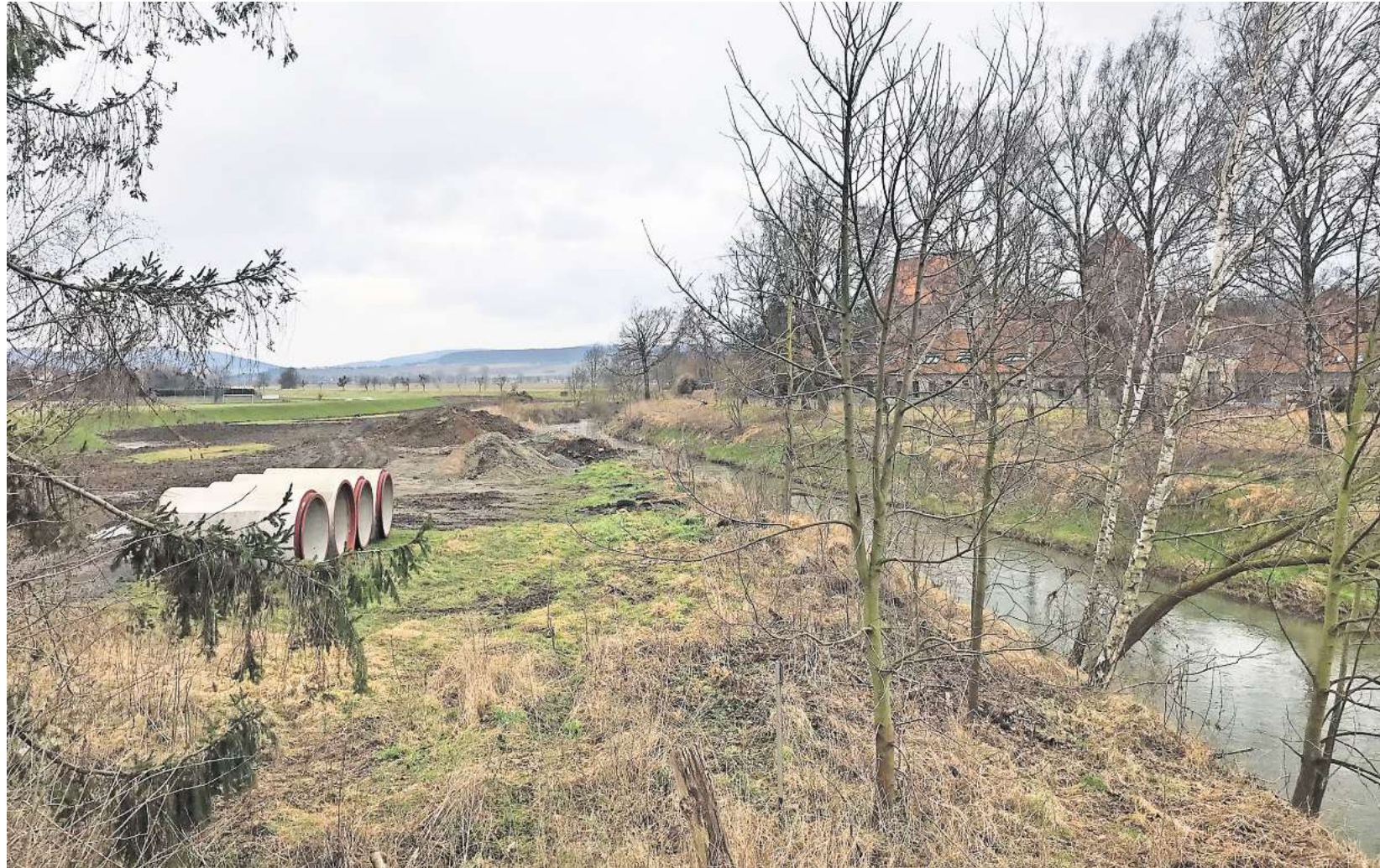
Ein Blick auf die Innerste an der Domäne Marineburg. Hier werden die Dämme von Innerste und Louisgraben saniert. Künftig soll sich dort eine große Rückstaufläche erstrecken.
