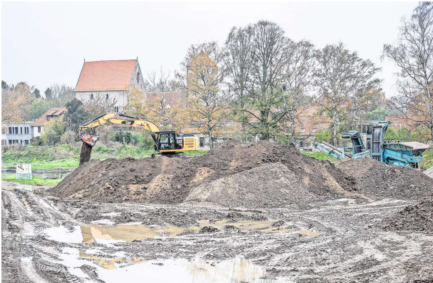
In den vergangenen Wochen wurde im Bereich des Innerste-Dammes an der Domäne Marienburg kräftig gearbeitet.
