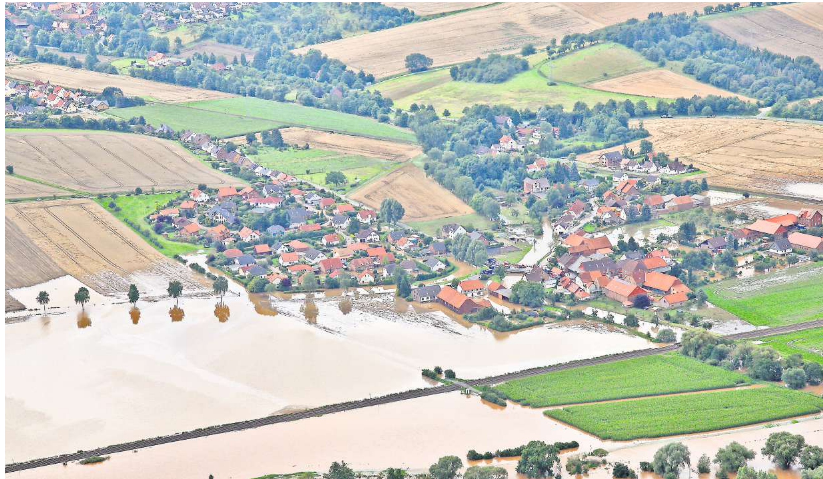
Unter anderem am linken Rand entlang des Baugebietes Fohlenfeld und rechter Hand der Straße Sonnenberg sollen Verwallungen die Grundstücke bei einem neuen Hochwasser vor Überflutung schützen.
